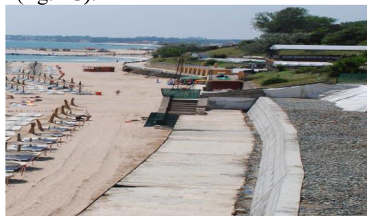
Fig.5. Lucrări de consolidare a falezei la Eforie Nord
